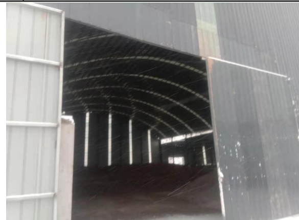
封闭料棚推拉门（半开状态）
