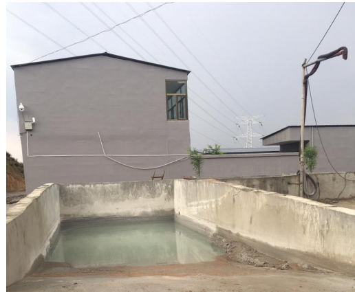
80m 3 沉淀池（搅拌机冲洗废水收集池）
