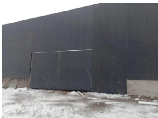
全封闭料棚（出入口设推拉门）
