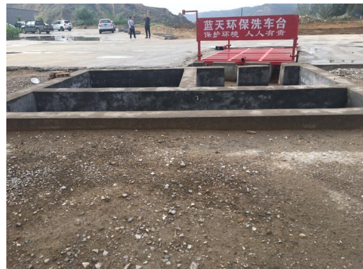
80m 3 沉淀池（搅拌机冲洗废水收集池）
