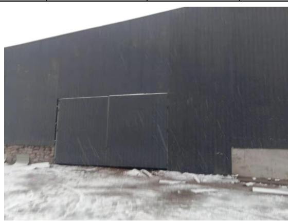
全封闭料棚（出入口设推拉门）
