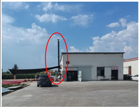
燃气锅炉 12m 高排气筒
