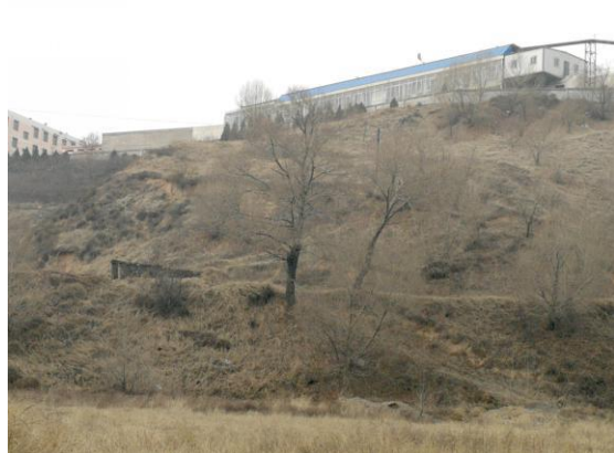
气化站西北侧
