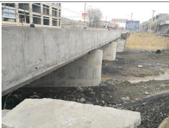
随桥敷设穿越点
