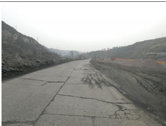
气化站东侧工业四路
