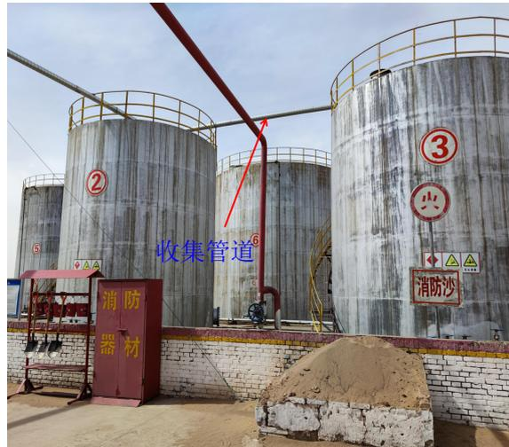
废气收集管道（接入回收系统）
