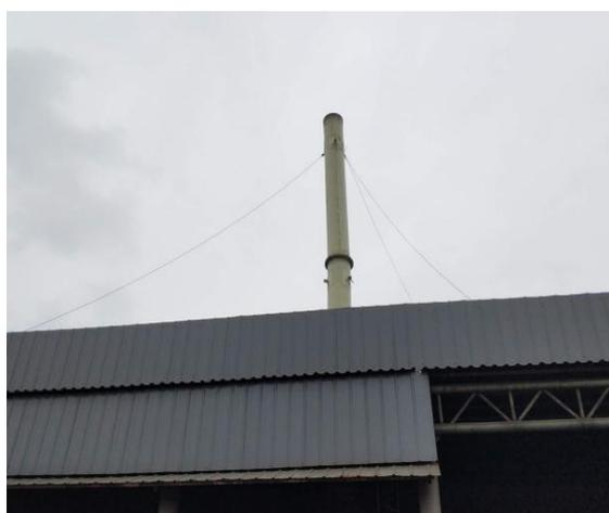
热解炉 15m 高排气筒
